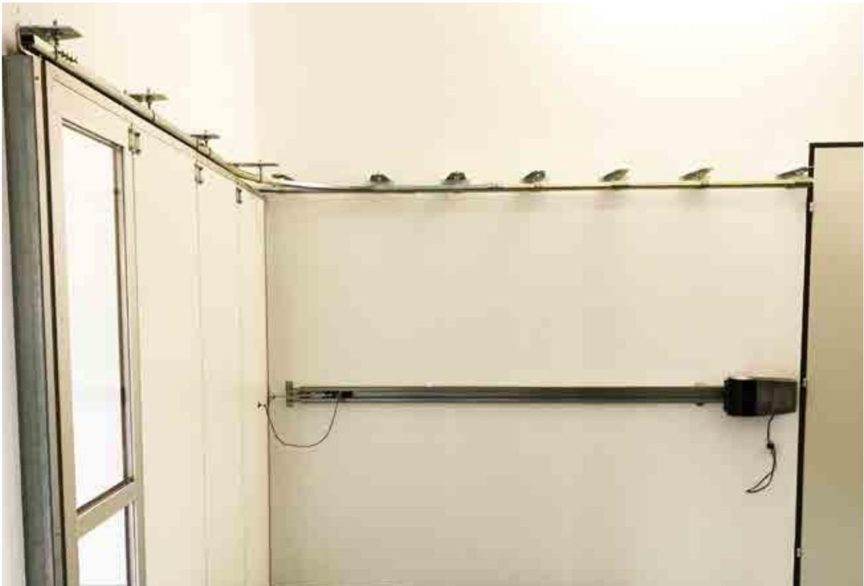
Seitensektionstor mit Doppelaufschiene mit platzsparendem seitlichem Einlauf.
