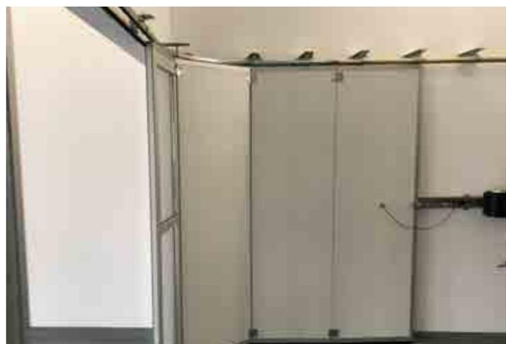
Seitensektionstor mit Antriebsmotor einlaufseitig
