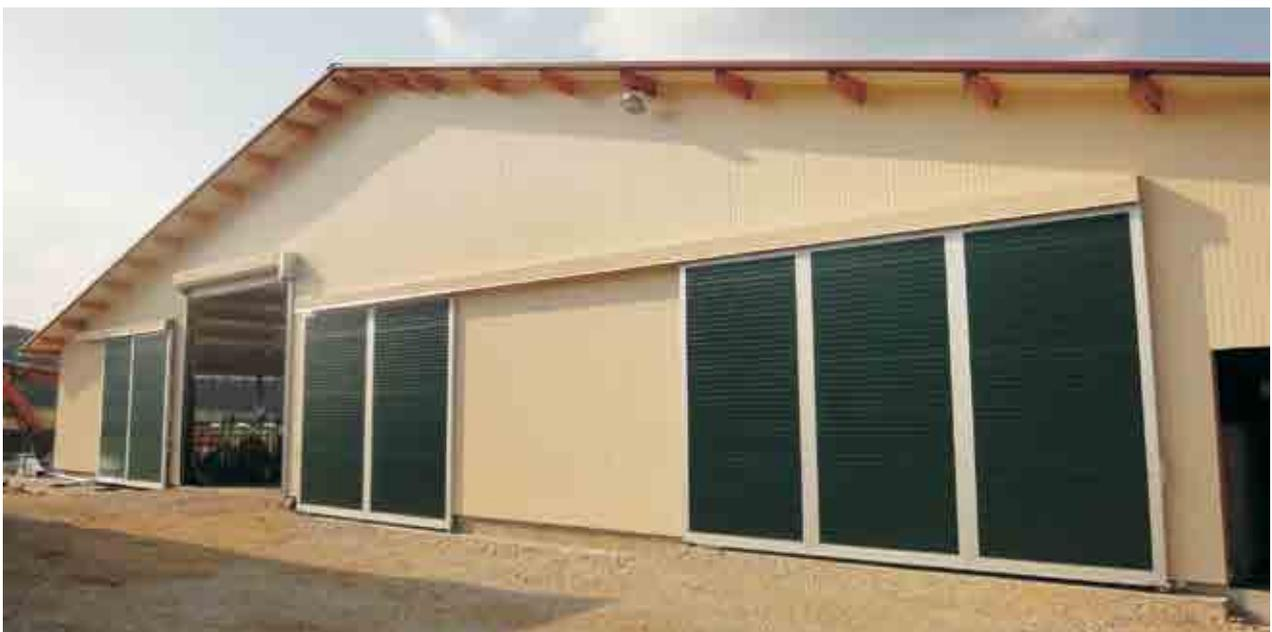
Wetterschutzblende für Laufschiene und Muffen. Schiebetüre Alu -Rahmensystem mit ISO Paneele und U - Bodenführung im Torblatt .
