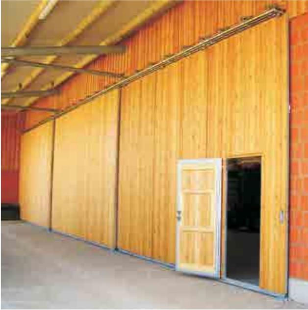
Mehrflügelige Toranlage mit verstellbaren Wandwinkeln für 3 Laufschielen, mit höhenverstellbaren Muffen und doppelpaarigen Rollapparaten, Gehüre integriert.
