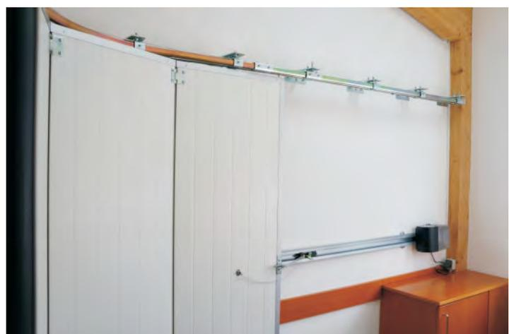
Seitensektionstor mit Antriebsmotor einlaufseitig
